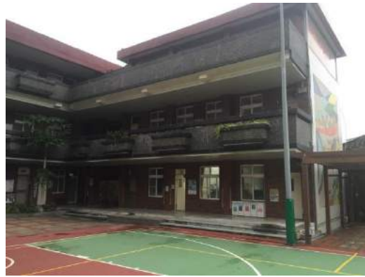
東側教學大樓(拆除)
