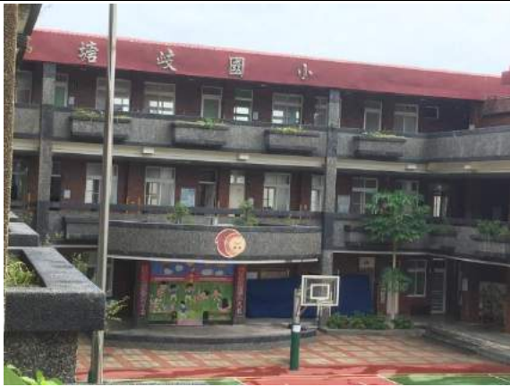
教學大樓(拆除)
