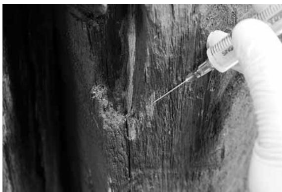
圖 34 將調配後的 B-72 樹脂置入針筒內，分次加固於有腐朽菌之區域（朱銘美術館提供）
