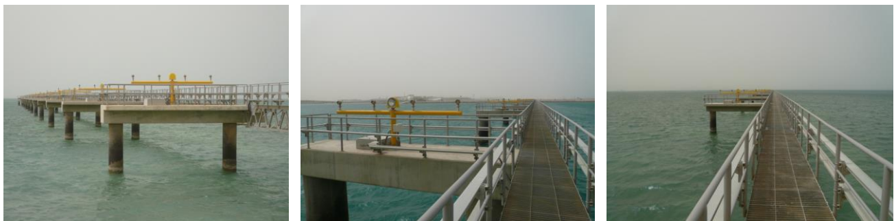
圖 5.1-11 機場跑道進場燈系統(ALS)設置於海中之案例
